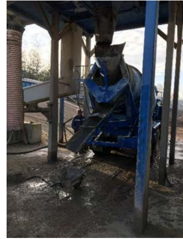
Plnění mixu betonovou směsí
