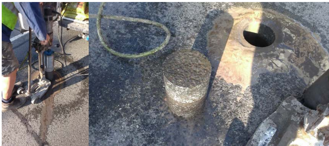
Obrázek 1: Provádění vývrtu
