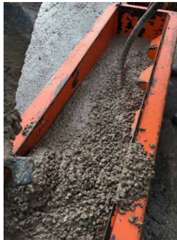
Plnění formy a vibrování betonové směsi ponorným vibrátorem
