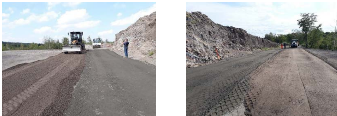
Obrázek 3: Pokusný úsek během hutnění (vlevo), po zhutnění (vpravo)
