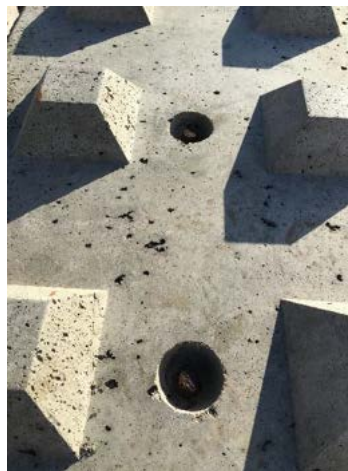
Zámečky a manipulační úchyty prvků prefabrikovaných základů
