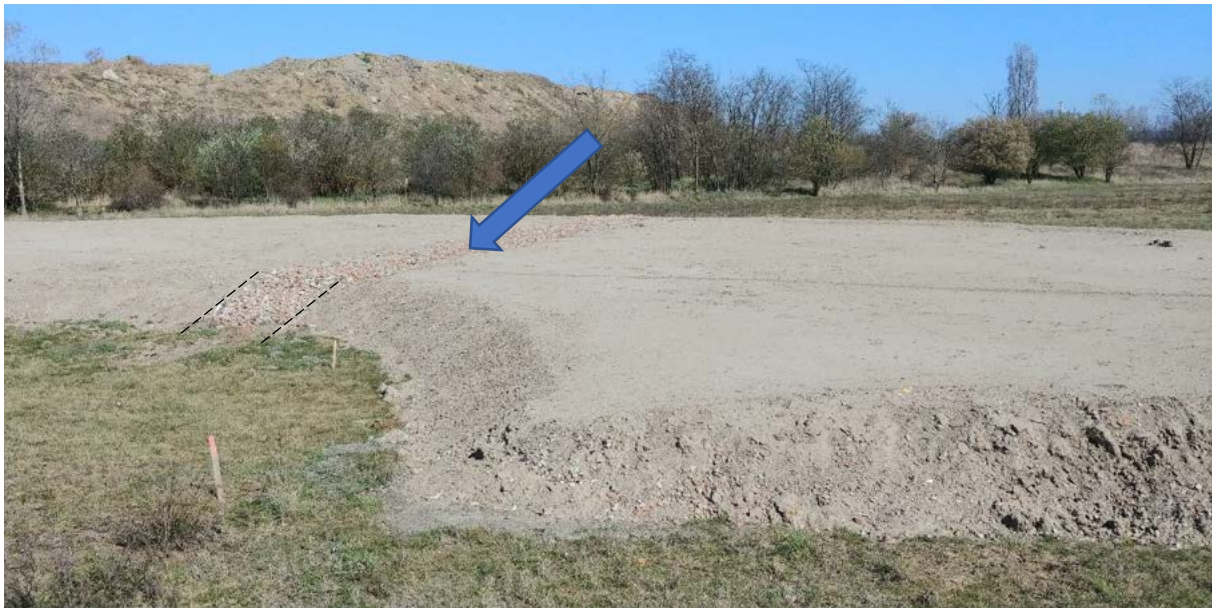
Obrázek 3 Ztužující, drenážní žebro v dolní části prováděného vrstevnatého násypu
