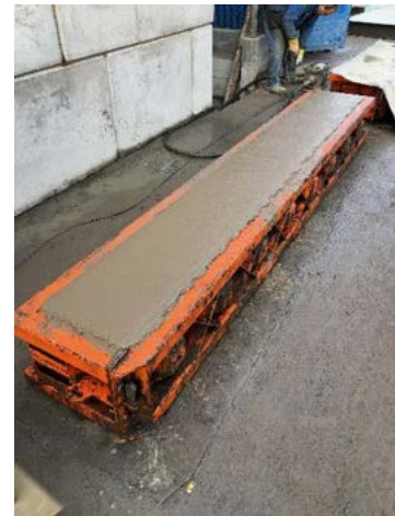
Forma prefabrikovaných základů z betonu s RCK – po betonáži
