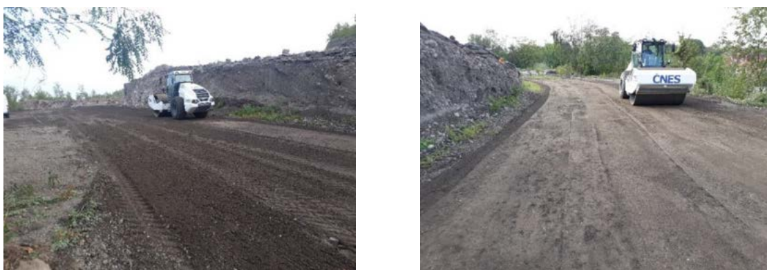
Obrázek 2: Podklad pro KSC vrstvu – před hutnění (vlevo), po hutnění (vpravo)
