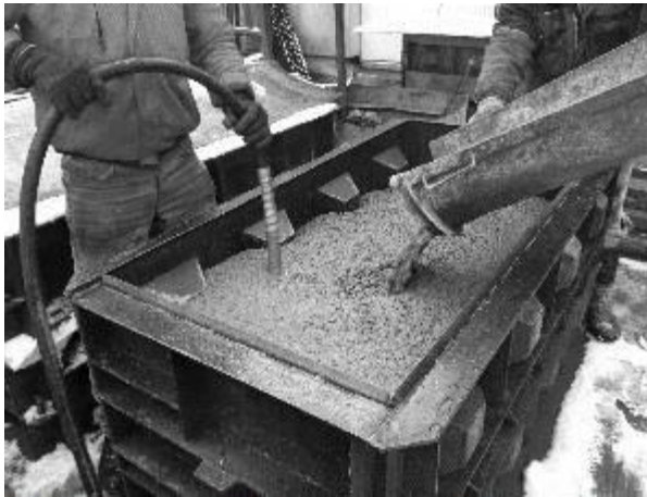
e) Plnění formy a vibrování betonové směsi ponorným vibrátorem
