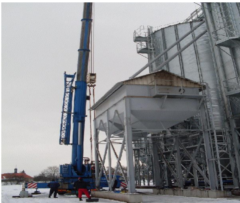
Obr. 2 Instalace tenzometrických snímačů pod podpěry zásobníku
