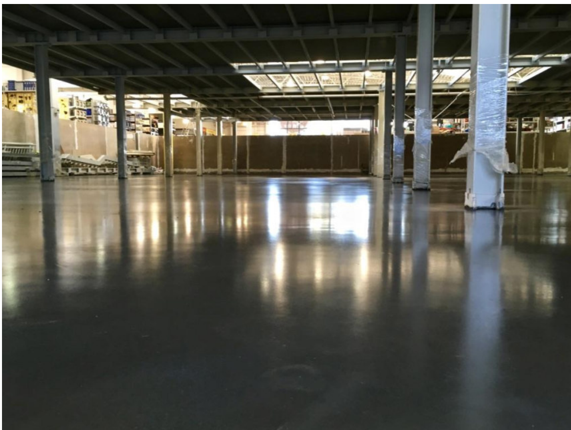
Obr. 3 Průmyslová podlaha po vyleštění a ošetření, 2018
