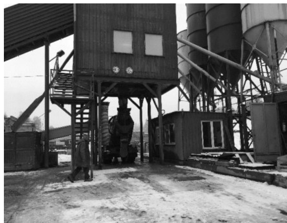
b) Pohled na betonárku- plnění mixu betonovou směsí
